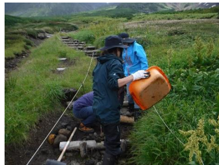
■補修作業の様子
