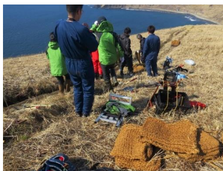
■歩道補修の様子
