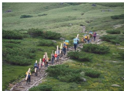
■補修資材運搬の様子
