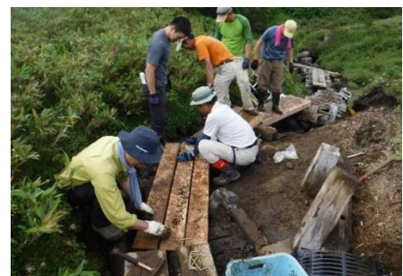
■補修作業の様子
